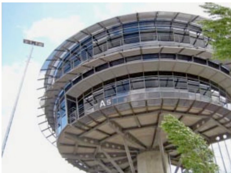
Bild 2: Stellwerk des Bahnhofs „Alte Süderelbe“ der Hafenbahn Hamburg
